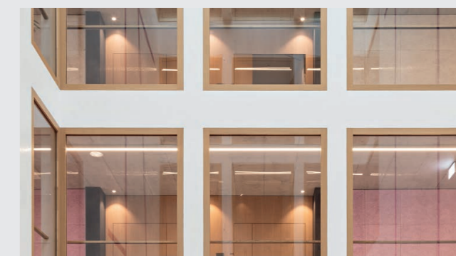
Sécurité anti-chute et protection incendie : la FeuerschutzTeam propose ici une attestation de l'élément entier, structure incluse.
