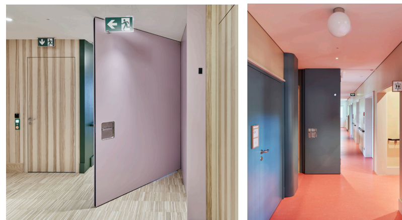
Brandabschnittstor ohne (links) und mit Klappflügel (rechts)
