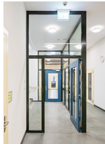
◀ Festverglasung mit integrierter Türe mit Fluchtwegfunktion
