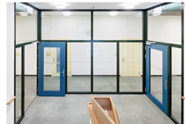
Janisol-Metallverglasung, Holztürblatt, gespritzt, mit Glaseinsatz
