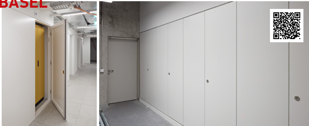
▲ Schachtfront EI30 RF1, 2-flg. Türfront mit Oberblende und darin integriertes Weichschott mit Kabelzuleitungen, Biozentrum Basel, Umsetzung Schreinerei Schneider AG, Architekturbüro Ilg Santer Architekten
