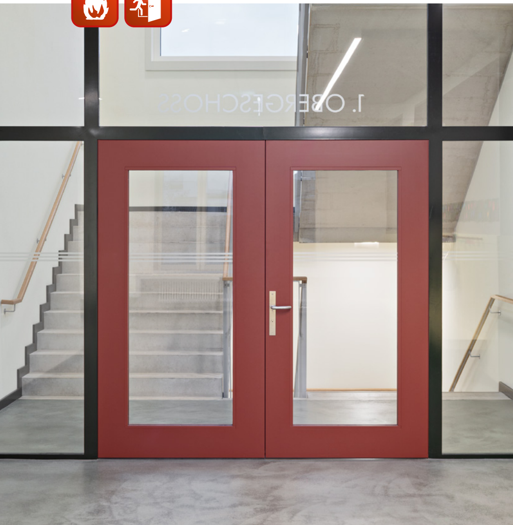
◀ Festverglasung mit integrierter Türe mit Fluchtwegfunktion
