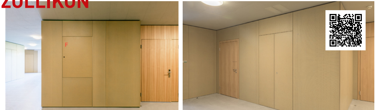
▲ Schachtfront EI30 RF1, 2-flg. Türfront in Cemcolor ausgeführt, WPZ Zollikon, Umsetzung von Büren + Sommer AG, Architekturbüro Ballmoos Krucker Architekten AG
