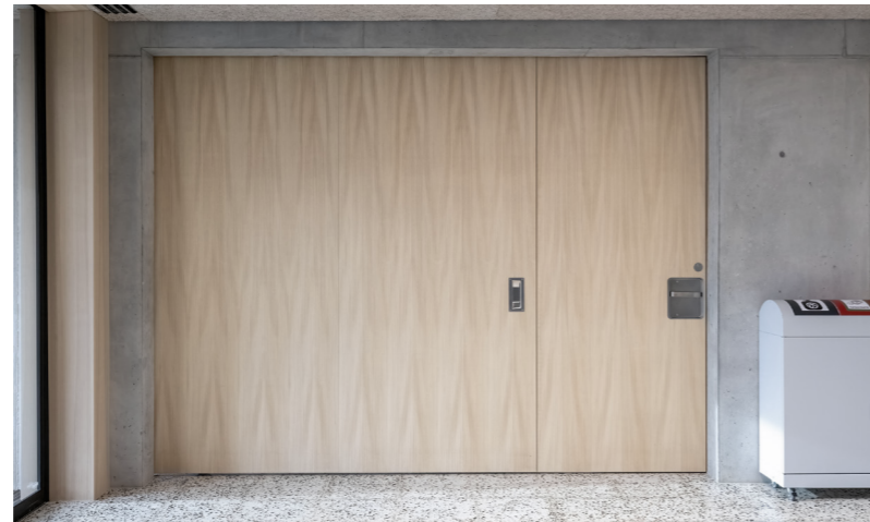
Porte coulissante au collège d'Ollon.
